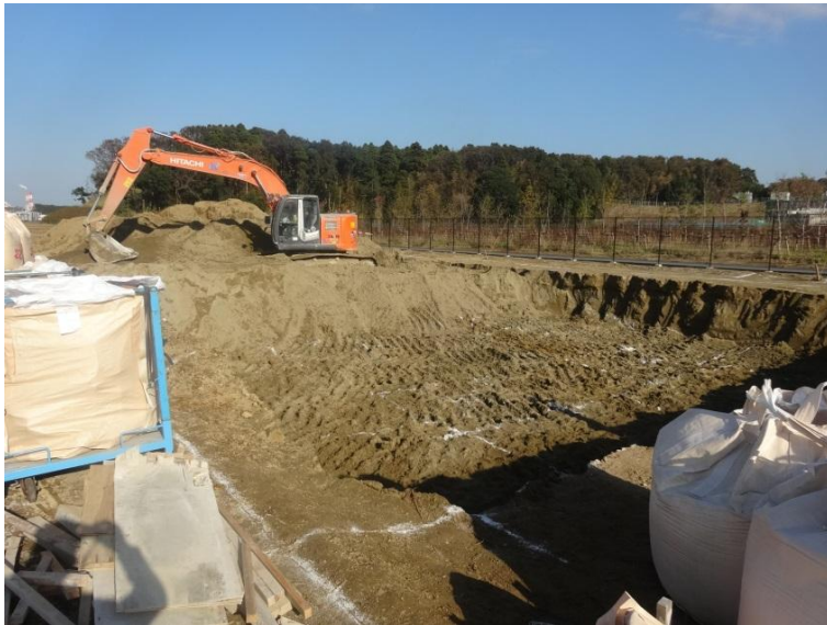
静置タンク 地盤改良
