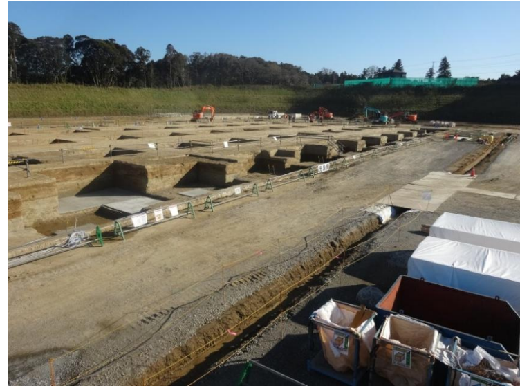
充填包装棟 基礎掘削
