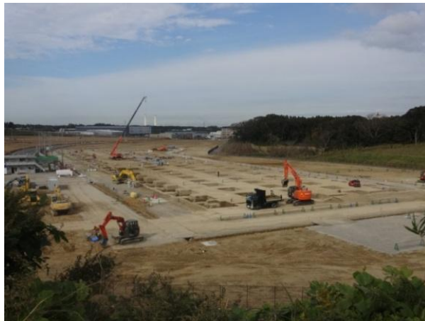
袖ヶ浦工場建設状況
