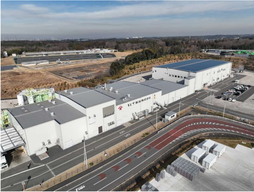
【太陽光パネル設置後の袖ヶ浦工場】
